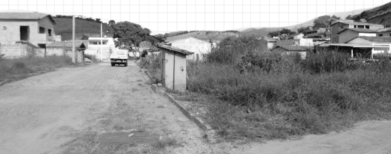
Córrego Estiva e área de inundação
