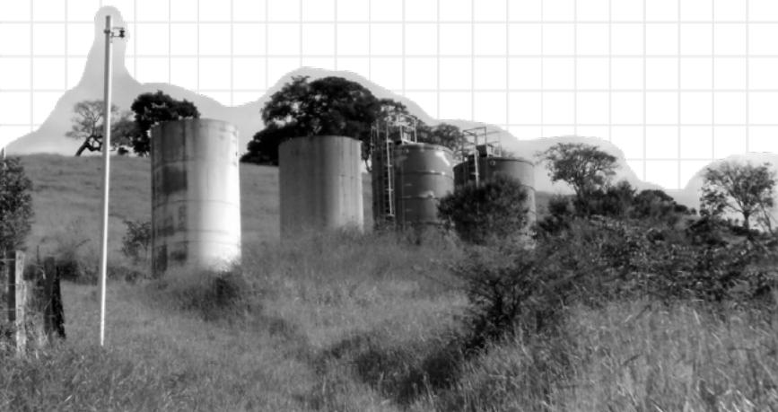
Reservatórios no bairro Monte Verde
