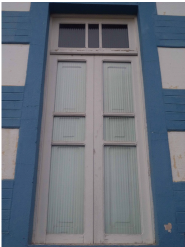
3 - Janela - Medidas 2.45m x 1.00m – Visão Exterior
